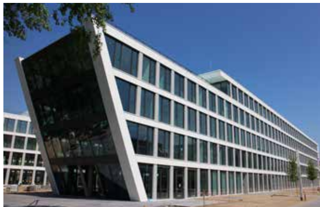
Bonner Bogen - Alemania - Clima Canal 4 tubos
